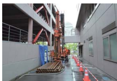
ボアホール掘削作業
