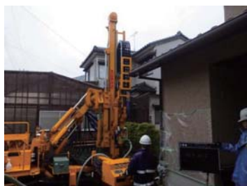
ボアホール掘削作業
