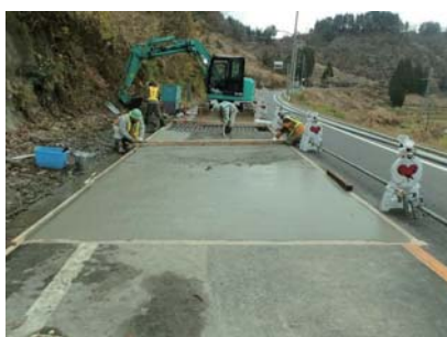
コンクリート打設
