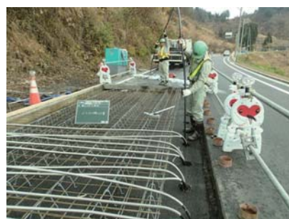
ヒートパイプ挿入
