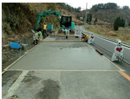
コンクリート打設
