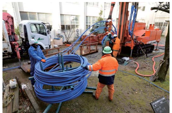
採熱管(Uチューブ)挿入
