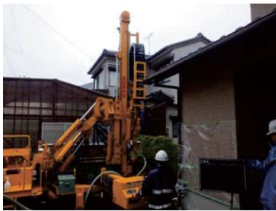
ボアホール掘削作業
