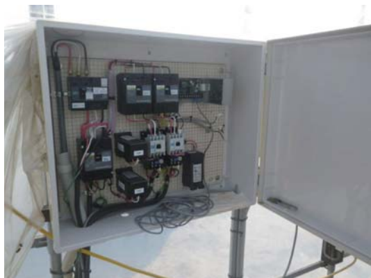
既設分電盤の確認
