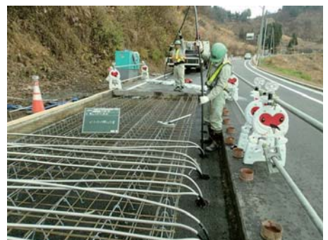
ヒートパイプ挿入
