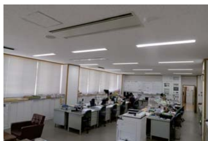
空調エリア(職員室)
