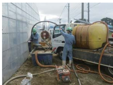
新設井戸工事 (手掘り！井戸)
