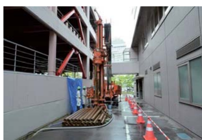
ボアホール掘削作業
