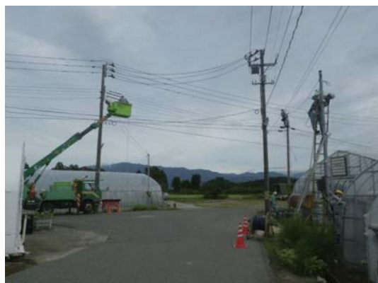
受電設備工事
