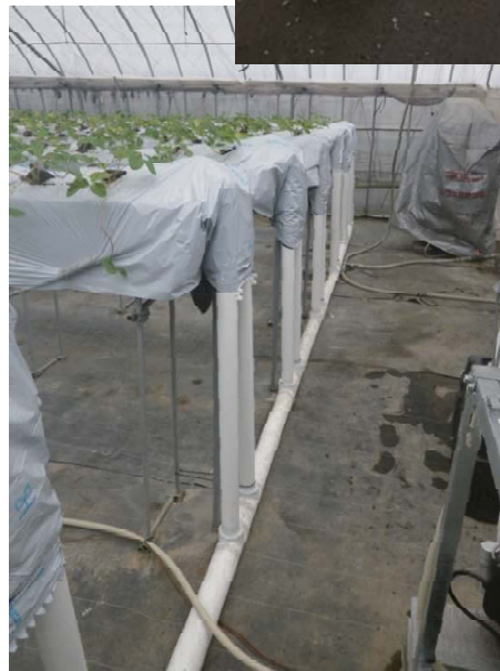
分配配管の保温
