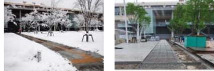
地中熱ヒートパイプによる車道融雪事例(新潟バイパス弁天IC)
