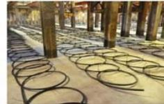
小田急電鉄東武北沢駅のトンネル本体下に設置した水平型地中熱交換器 (地底下約15m)
