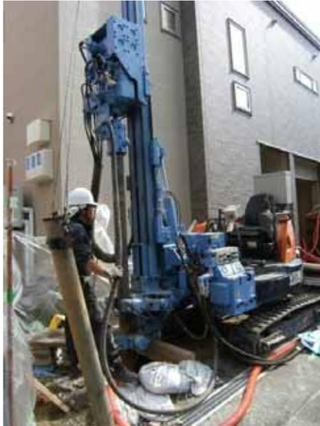
○採熱管挿入工事(25A高密度ポリエチレン管)
