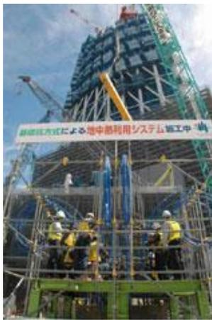
基礎杭を活用した地中熱交換器の設置工事
