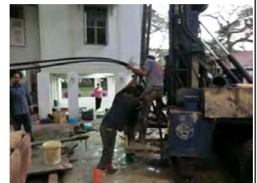
50m深まで100mのパイプ設置
