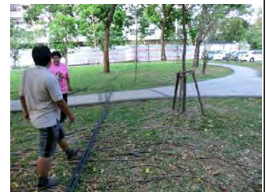
2坑井掘削とパイプ挿入直後
