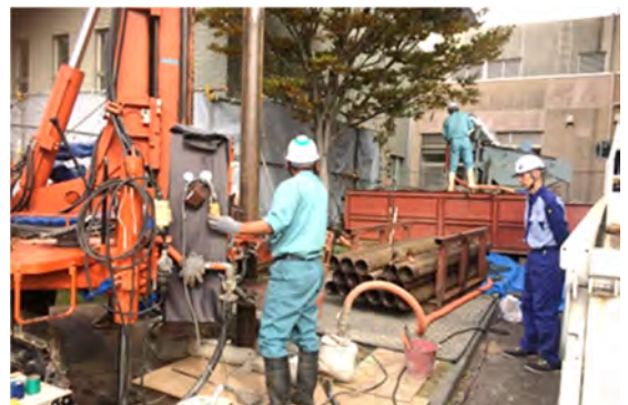
TRT試験(刈羽村生涯学習センター)
