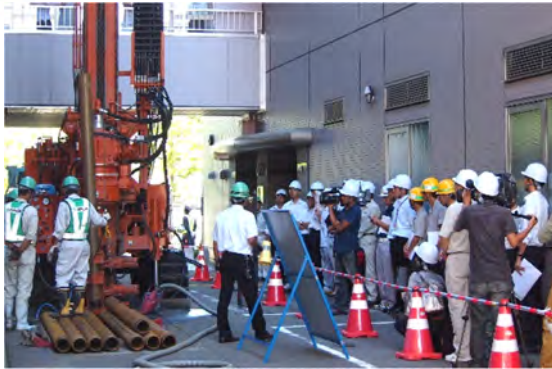
ボアホール設置工事現場(興和ビル)
