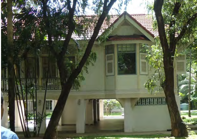
学長室（建物の右側に熱交換井を掘削）
