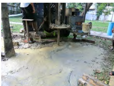
掘削泥水の流れ
