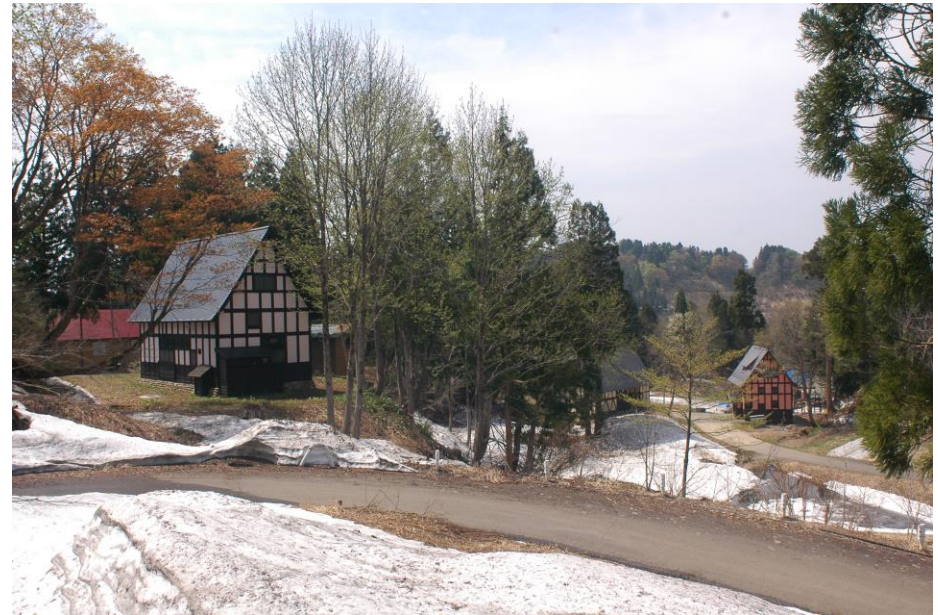
竹所で手掛けた古民家再生事例（一例）
